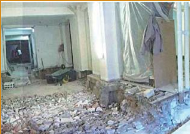
Reconstruction de la dalle.
