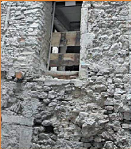
Mur traditionnel en cours de restauration
