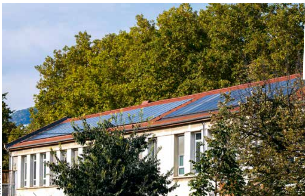
École Jean-Racine : 200m 2 de panneaux photovoltaïques ont été installés en deux phases.
