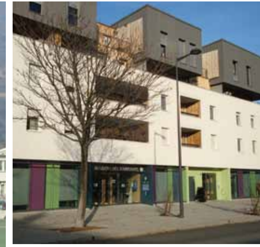
Maison des habitants rue Anatole France
