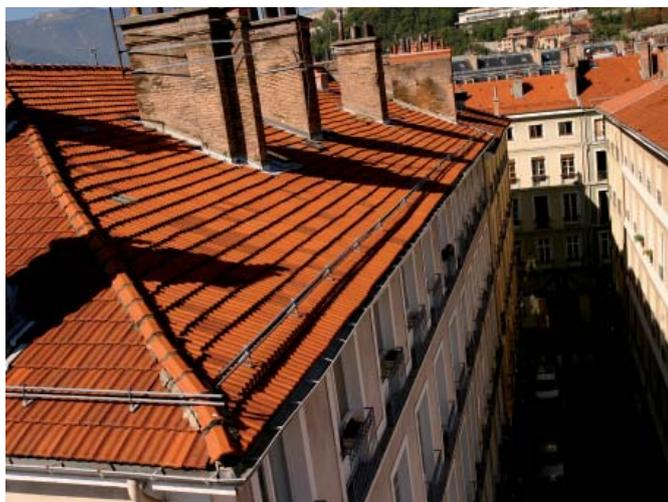
Les dépassées de toiture apportent à la façade ombre et protection contre les intempéries. Elles sont parfois habillées en sous-face par un caisson en bois qui masquent les voliges. Lorsqu'il existe, ce caisson est à préserver. Voliges et caissons sont à peindre en harmonie avec les couleurs de la façade.
