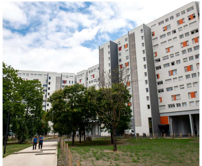
Réhabilitation du 56 galerie de l'Arlequin © Jean Sébastien Faure, Ville de Grenoble, 2022
