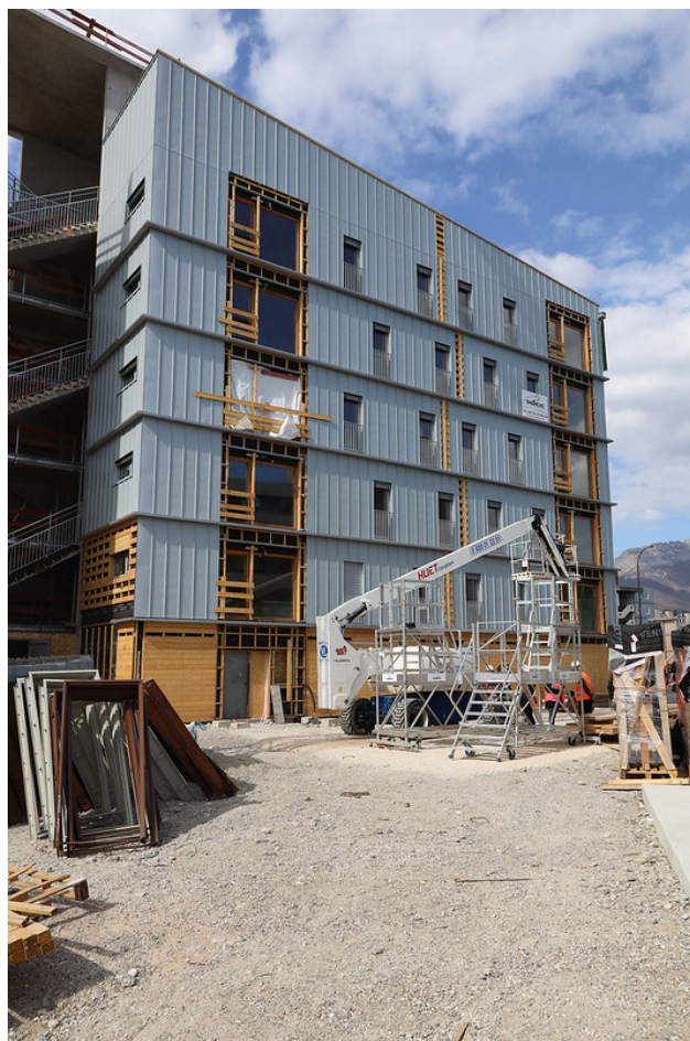
Visite du chantier Hautbois d'ACTIS © Thierry CHENU © 2021
