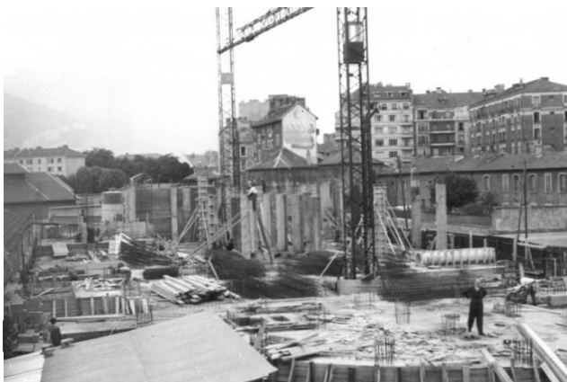
1957_06_14_L'architecte en visite de chantier ©Atelier Benoit, Architectes depuis 1897, 12 place Victor Hugo, Grenoble.
