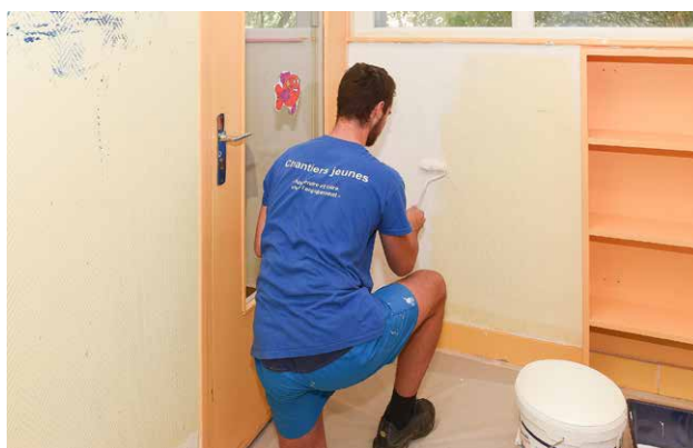
Travaux dans les écoles été 2022, Nicolas Chorrier (1) et Grand Châtelet (2 et 3) © Alain Fisher, Ville de Grenoble 2021
