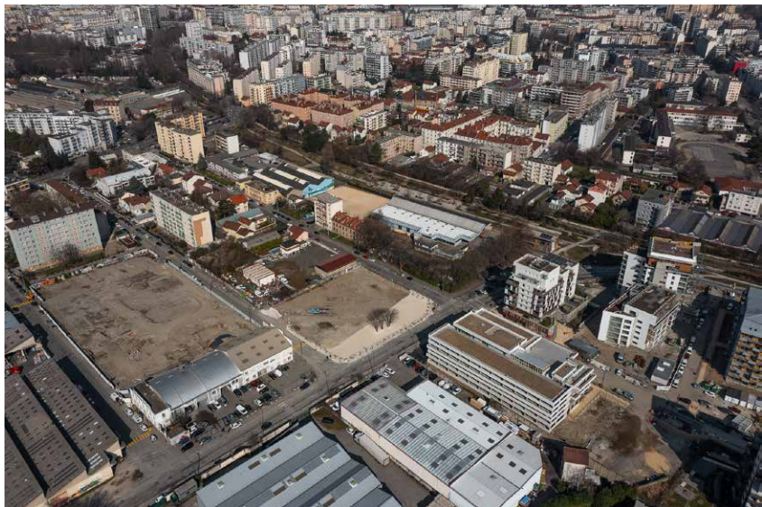
Ecoquartier Flaubert © Ville de Grenoble 2022
