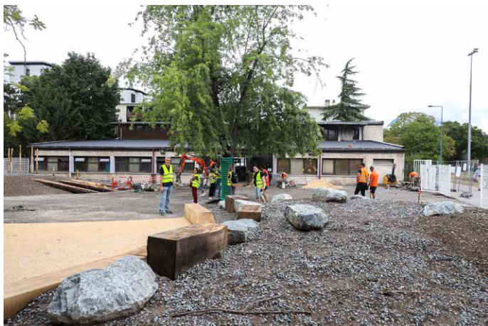
Travaux de la cour de récréation Christophe Turc © Auriane Poillet, Ville de Grenoble 2022
