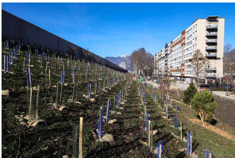
Chantier ouvert au public (COP) pour la plantation d'arbres sur le talus du mur anti-bruit de l'A480, quartier Mistral.
